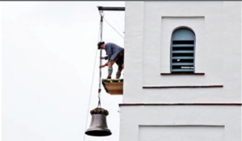
Eine der beiden Glocken kurz vor dem Ziel
